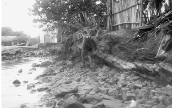
Figura 6. Bloques de roca caídos pertenecientes a una terraza fluvio-marina ubicada en la zona central de Paso Nueva causa de la socavación producida por el oleaje. Nótese como la disposición de los estratos favorece la acción del oleaje para producir la erosión.
