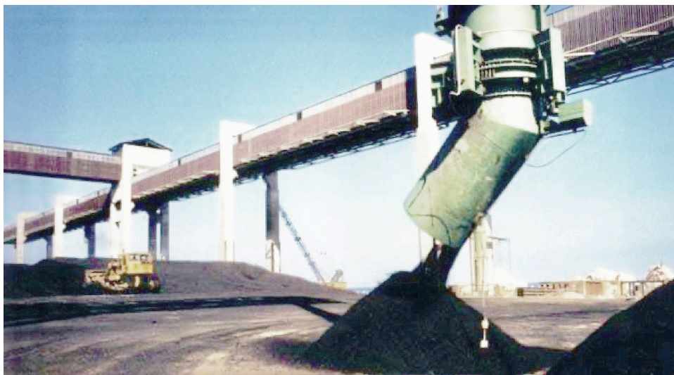
Figura 2. Descarga de carbón en campos de acopio mediante cinta transportadora
